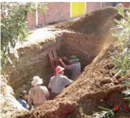
Obras para el reciclaje de agua en liceo ariqueño
